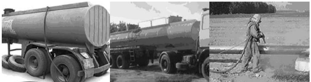
Пескоструйная обработка применяется при подготовке поверхности к окраске или для антикоррозионной обработки и обеспечивает высокую степень зачистки любой поверхности от продуктов коррозии различного происхождения, нагара, слоистой окалины, битума, мазута и др.
